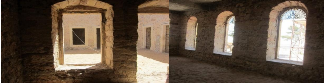
شكل (21) ، (22): عناصر التهوية والإضاءة الطبيعية داخل القلعة
