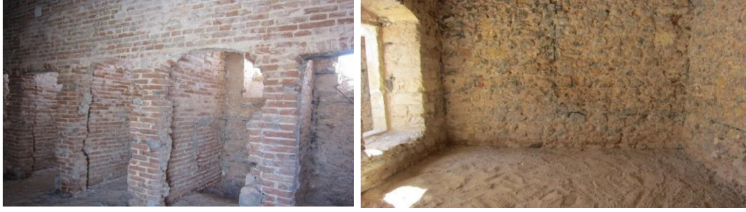
شكل (19) ، (20): الجدران الحجرية الأصلية، ومواد البناء التقليدية
