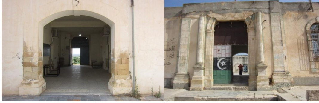
شكل (13) ، (14): المدخل الرئيسي للقلعة من الداخل والخارج.
