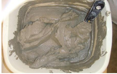
صورة (10): خلط المكونات بعد إضافة الماء
