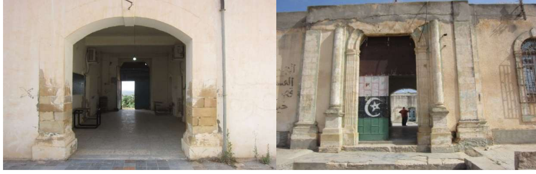
شكل (13) ، (14): المدخل الرئيسي للقلعة من الداخل والخارج.
