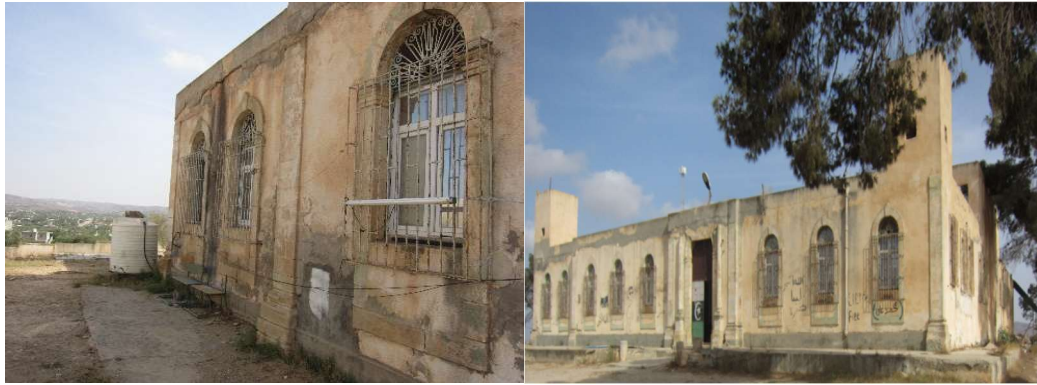
شكل (11) ، (12): الواجهة الرئيسية للقلعة، وتفاصيل الفتحات والعناصر المعمارية بالواجهة
