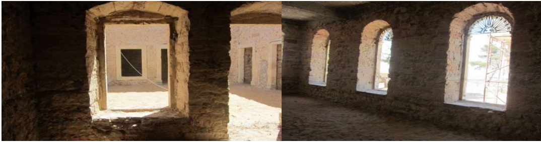
شكل (21) ، (22): عناصر التهوية والإضاءة الطبيعية داخل القلعة
