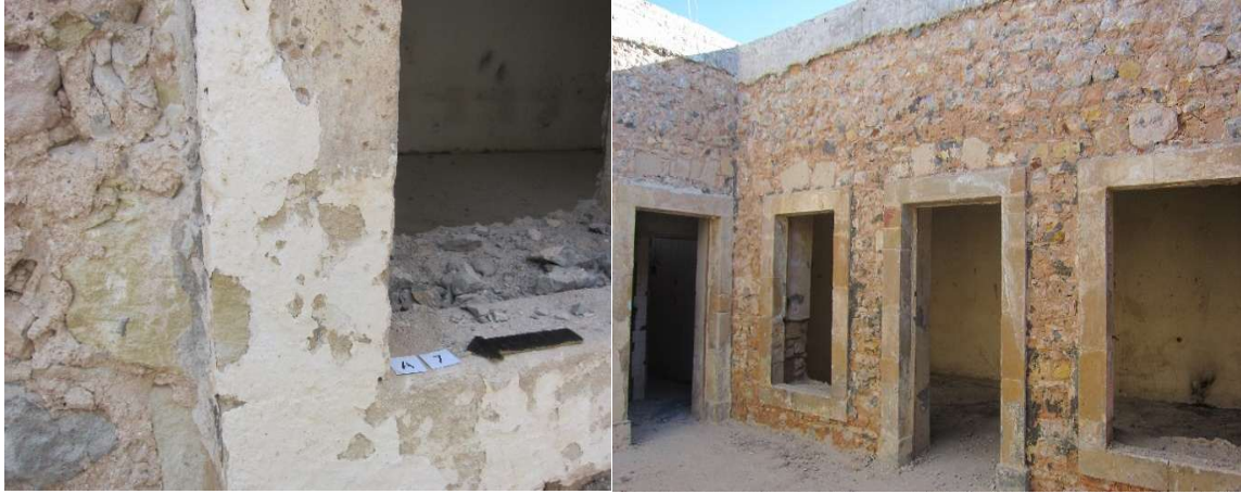
شكر رقم (5) ، (6): الجدران الحجرية الأصلية المستخدمة في بناء القلعة، والتفاصيل المعمارية توضح سماكة الجدران
