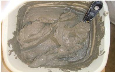
صورة (10): خلط المكونات بعد إضافة الماء
